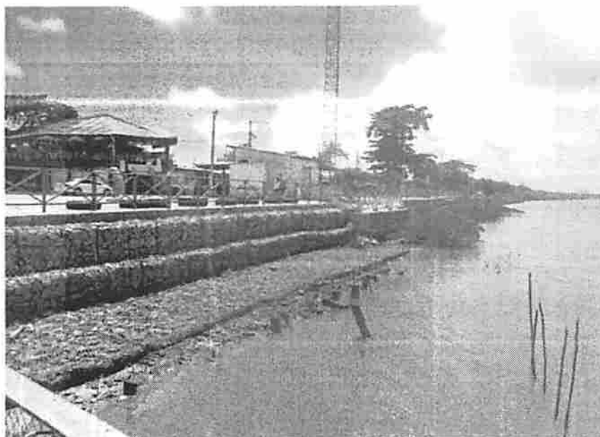
Figura 002 – Gabiões em granito e estrutura de concreto armado sob centro de atendimento ao turista
